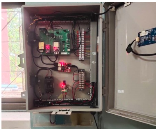
รูปที่ 4 การติดตั้งโครงสร้างระบบควบคุมอุปกรณ์ตรวจวัดภายใน
