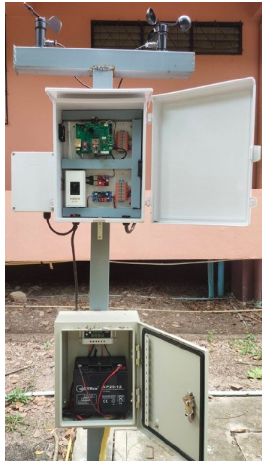
รูปที่ 5 การติดตั้งโครงสร้างระบบควบคุมอุปกรณ์ตรวจวัดภายนอก
