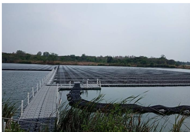
รูปที่ 1 ระบบ FPV ณ อ่างเก็บน้ำของมหาวิทยาลัยเทคโนโลยีสุรนารี ประเทศไทย
