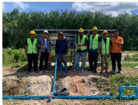
รูปที่ 5 การติดตั้งระบบสูบน้ำพลังงานแสงอาทิตย์
