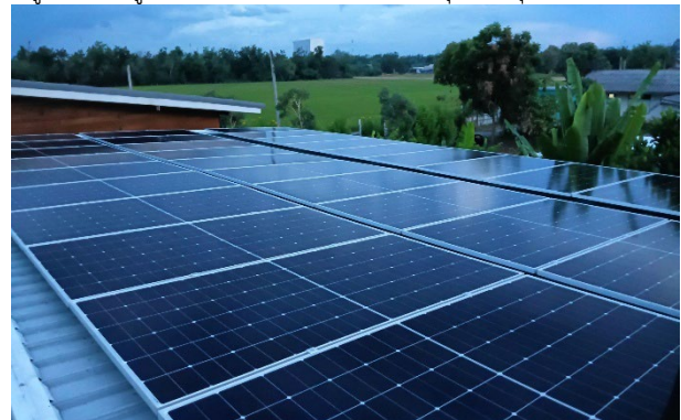
รูปที่ 4 แผงโซลาร์เซลล์ขนาด 580 W จำนวน 30 แผง
