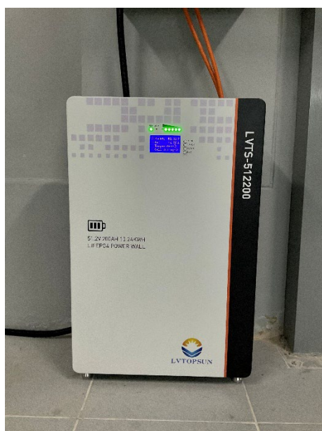
รูปที่ 6 แบตเตอรี่ลิเทียมฟอสเฟตขนาด 51.2V 200Ah 10.24 kWh
