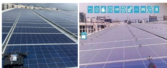
รูปที่ 5 การทดสอบหุ่นยนต์ทำความสะอาดแผงเซลล์แสงอาทิตย์ขนาดเล็ก ไปใช้งานในสถานที่จริง
