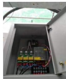
รูปที่ 7 ติดตั้งตัว Sender1 ที่ปั๊มน้ำ
