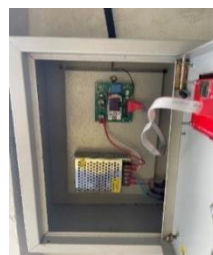
รูปที่ 9 ติดตั้งตัว Receiver ภายในอาคารสำนักงาน
