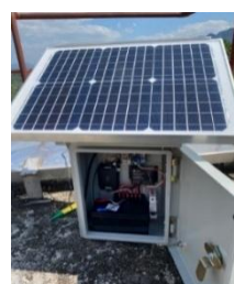
รูปที่ 8 ติดตั้งตัว Sender2 ที่ถังเก็บน้ำประปา
