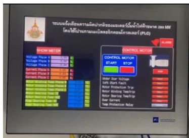
รูปที่ 12 การแสดงผลของจอ HMI ขณะแจ้งเตือน
